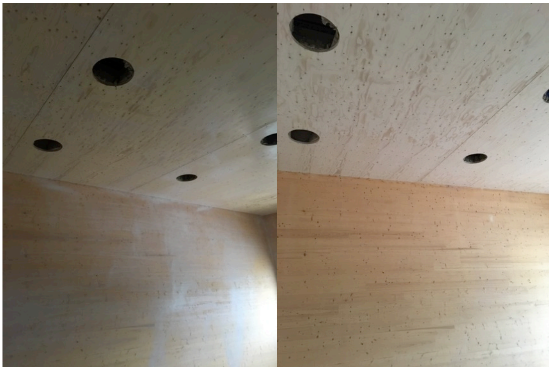
Photos 2 & 3 : Aspect du TEKNOSAFE 2467 frais appliqué et après 6 heures séchage. Un aspect transparent et mat régulier est la preuve d'une application réussie.
