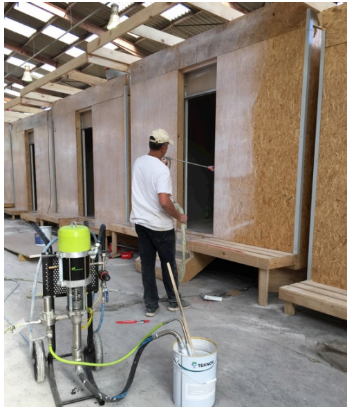
Photo 4 : Exemple d'application de TEKNOSAFE par pistolage airless sur chantier
